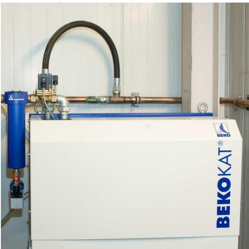
Mit dem BEKOKAT-Verfahren ist es erstmals möglich, konstant absolut ölfreie Druckluft mit einem maximalen Restölgehalt von kaum mehr messbaren 0,003 Milligramm pro Kubikmeter verdichteter Luft zu erzielen. Eine Qualität also, wie sie in den höchst anspruchsvollen Bereichen der Medizin und Pharmazie sowie der Lebensmittelverarbeitung und -verpackung benötigt wird.
