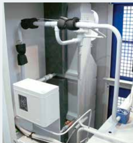
Interno di un essiccatore con rivestimento anticorrosione
