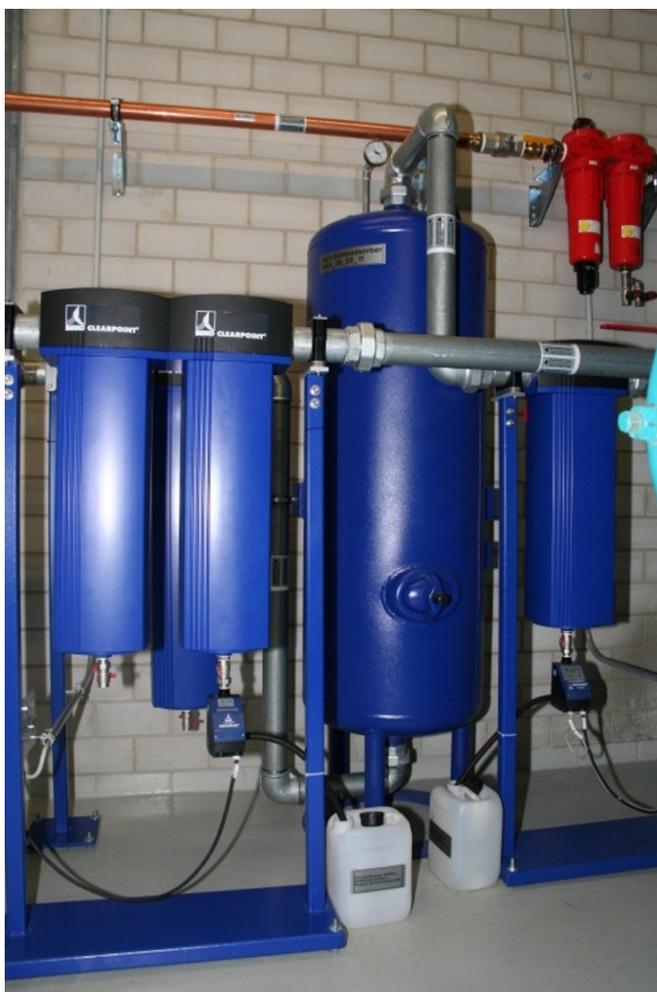
Per la scissione di particelle, nella linea dell'aria compressa sono stati infine installati filtri fine e microfiltri CLEARPOINT di BEKO con un grado di scissione che va da 0,1 µm a 0,01 µm. I refrigeratori d'aria di BEKO e gli essiccatori a freddo a valle del produttore di compressori servono a raffreddare e deumidificare l'aria compressa. Questa viene deumidificata a un punto di rugiada di massimo 5°C.
