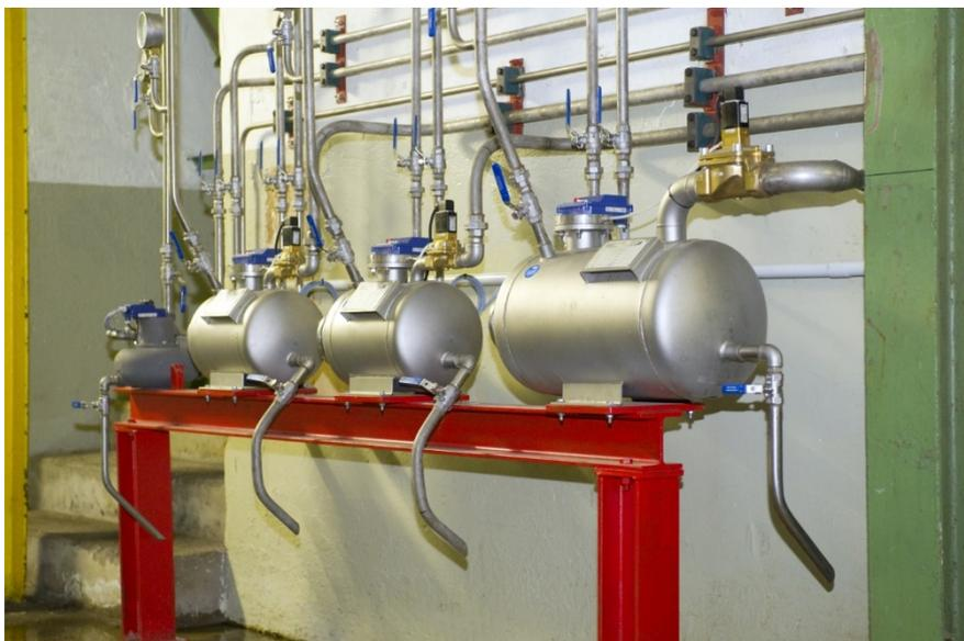
s'est tourné vers les autres éléments. Mais il n'y a pas eu beaucoup de temps de perdu : En à peine cinq semaines, entre le premier modèle de configuration et le « redémarrage » complet, l'ensemble de la purge des condensats était modernisé de manière fiable. D'autres BEKOMAT à régulation électronique du niveau se trouvent sur divers sécheurs frigorifiques du système pneumatique.
