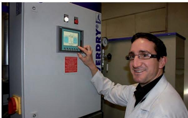
*Le tableau de commande multifonction permet à Mathieu Bouloux, leader infrastructures du site de Châtellerault de gérer de manière efficace les différentes fonctions du sécheur EVERDRY FRA-Vplus 1400C.*
