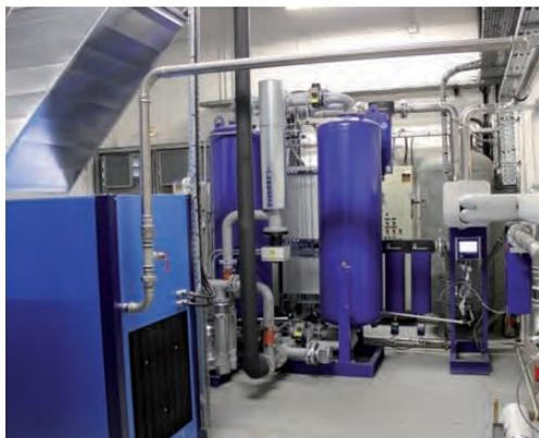
*Les exigences formulées par le client ont été satisfaites par une solution sur mesure composée de : filtres CLEARPOINT, purgeurs de condensats BEKOMAT, sécheur par adsorption avec régénération par apport de chaleur, modèle EVERDRY FRA-Vplus 1400C, dispositif de surveillance et de mesure d'hydrocarbures résiduels METPOINT OCV et unité de traitement des condensats BEKOSPLIT 13.*
