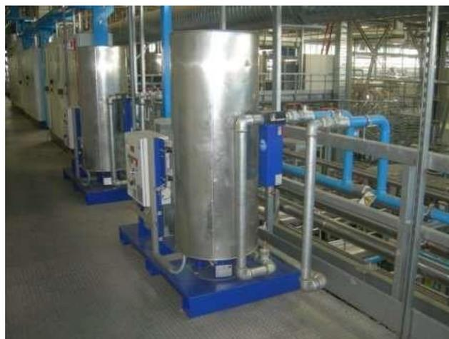
La solution BEKOKAT® de BEKO TECHNOLOGIES a répondu parfaitement aux exigences du client en raison de la qualité d'air comprimé constante proposée, de la fiabilité à long terme et des coûts d'entretien très faibles. Le système est certifié exempt d'huile et de germes et ce, pour des intervalles d'entretien supérieurs à 25 000 heures de service.
