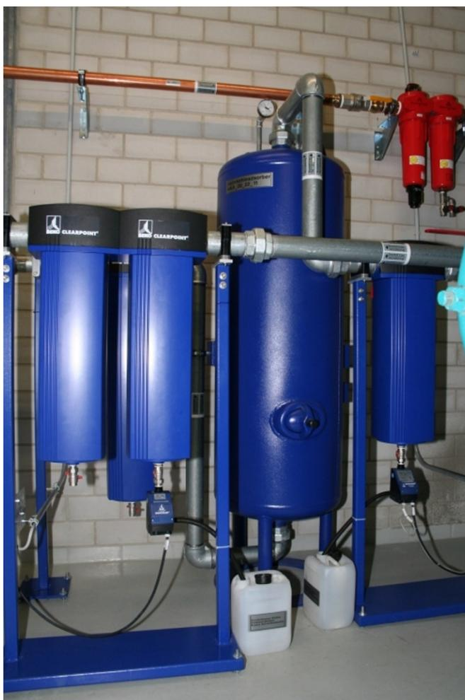
Para la separación de partículas, a continuación se han instalado filtros finos o super finos CLEARPOINT de BEKO con un grado de separación de 0,1  $\mu\text{m}$  y 0,01  $\mu\text{m}$  en el conducto de aire comprimido. Los refrigeradores de aire de BEKO y los secadores frigoríficos posteriores del fabricante de los compresores sirven para refrigerar y deshumidificar el aire comprimido. Este se deshumidifica a un punto de rocío a presión de 5 °C, como máximo.
