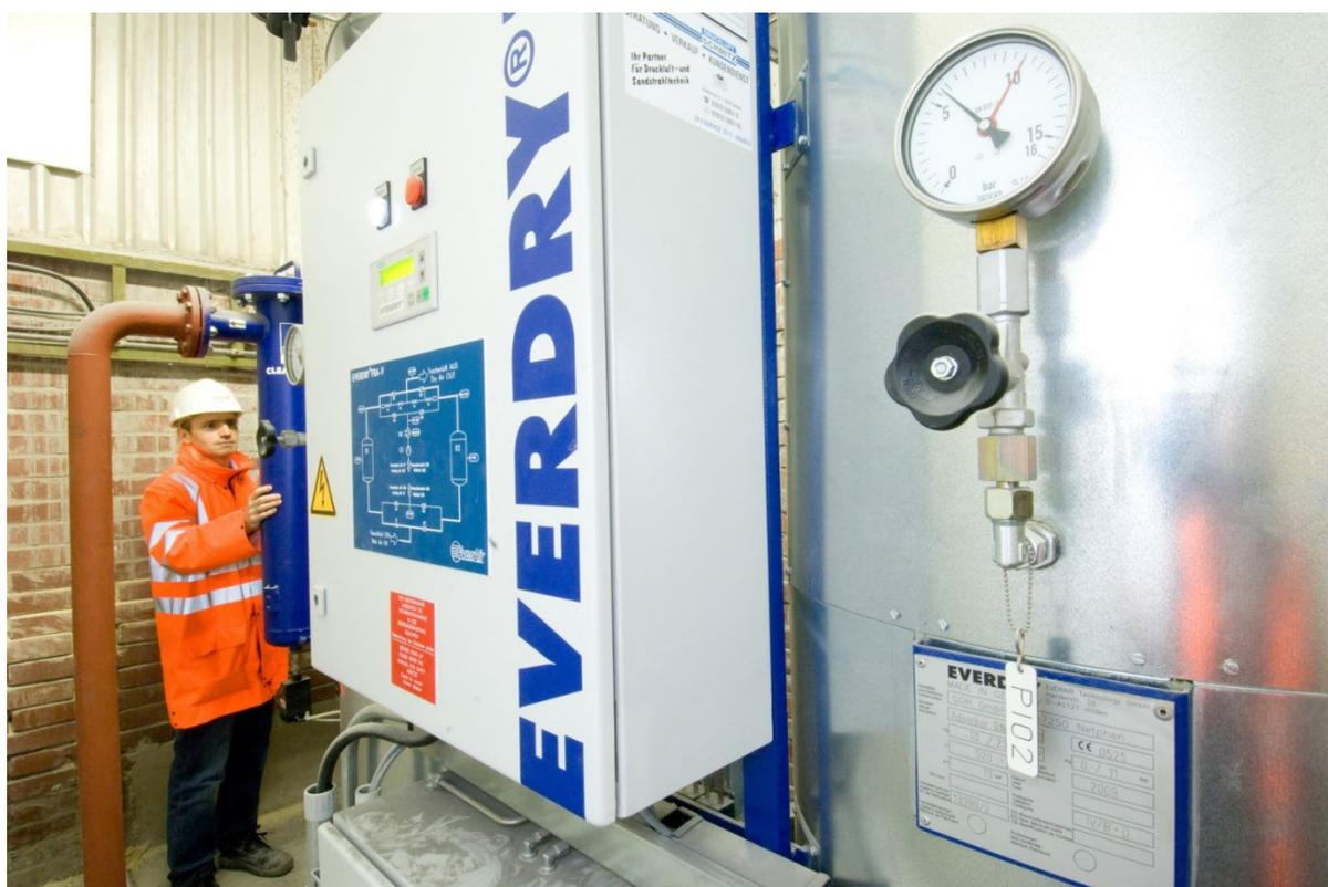
A través del funcionamiento en modo de presión del ventilador de regeneración se produce un aumento de temperatura que influye positivamente sobre la necesidad de potencia del calentador. El caudal del aire del ventilador evapora la humedad recogida en el secante y, a continuación, la deriva, con el caudal de aire, hasta la atmósfera. La desorción se realiza con optimización energética en un proceso de contracorriente.
