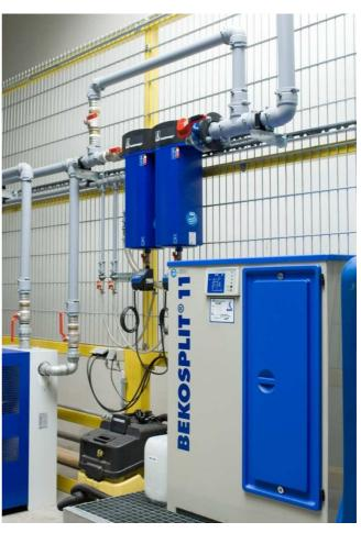
lässig adsorbiert. Das verbleibende, gereinigte Abwasser kann ohne Probleme in die Kanalisation eingeleitet werden.
