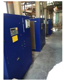
Bewegung ohne ungünstige Umleitungen. Dieser großzügig dimensionierte Counter-Flow-Wärmetauscher, der sich unter anderem aus einem Luft-Luft- und einem Luft-Kältemittel-Wärmetauscher zusammensetzt, kühlt die Druckluft bis auf eine Temperatur von plus zwei Grad Celsius herunter, wobei die Baugröße des Wärmetauschers nicht nur eine besonders effektive Abkühlung begünstigt, sondern auch den Strömungswiderstand auf ein absolutes Minimum senkt.
