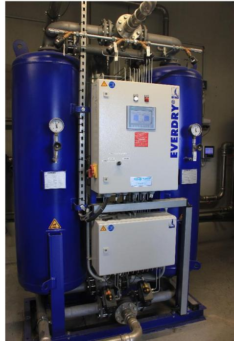
Der Adsorptionstrockner EVERDRY ist das zentrale Element der Druckluftaufbereitungsanlage.
